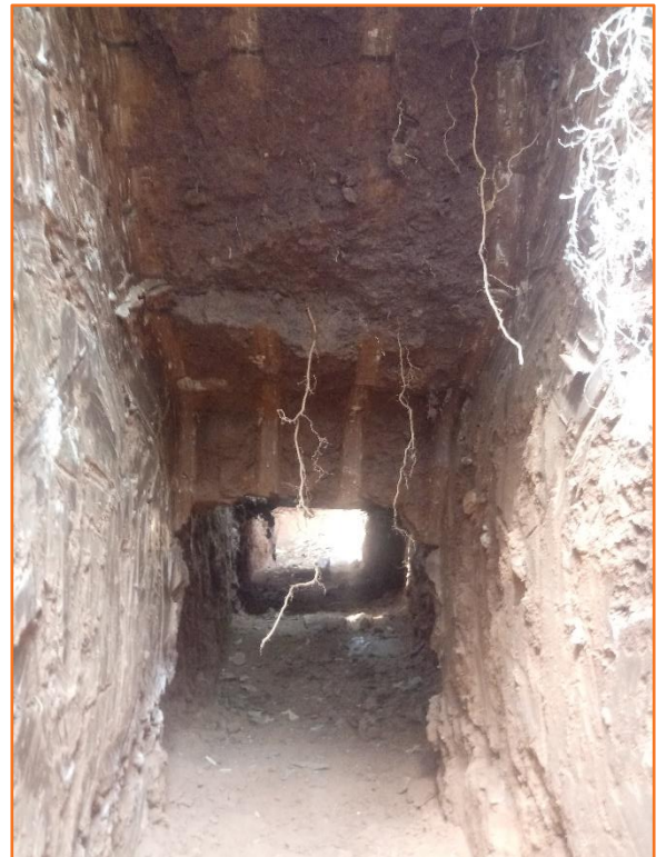
Foto 4. Excavació en mina per la part interior del mur de finca de l'hospital, on també es pot observar el substrat geològic.
