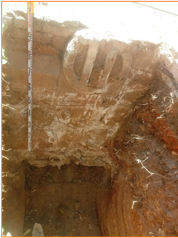
Foto 7. Foto de l'alçat de mur de finca de l'hospital un cop fet el rebaix de terra.
