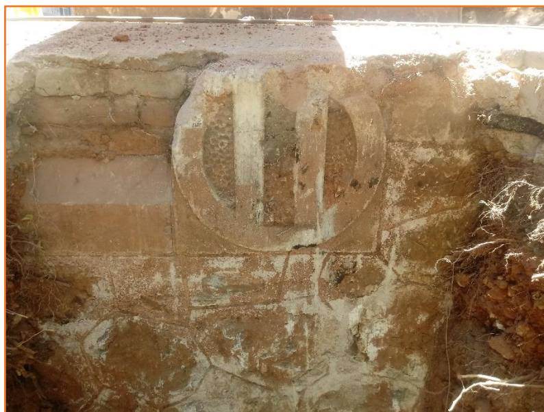
Foto 9. Foto de detall de l'escut gravat en el mur de finca.
