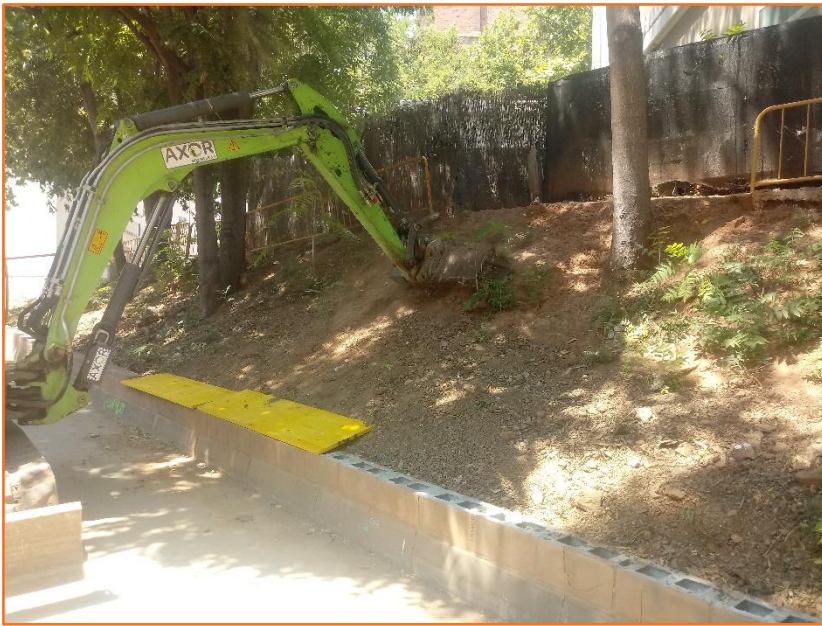
Foto 1. Tasca de regularització del terreny amb pala plana.
